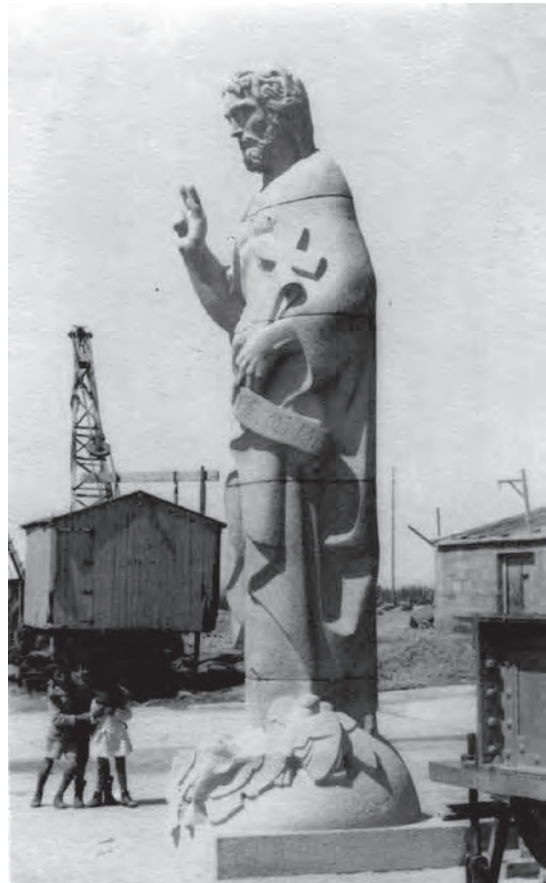
José Capuz Monumento al Sagrado Corazón de Jesús 1944 Model en escaiola | Modelo en escayola Puerto de Tarifa (Cádiz) Col·lecció fotogràfica | Colección fotográfica de la Dirección Facultativa de las obras de construcción del Puerto de Tarifa Archivo de la Autoridad Portuaria de la Bahía de Algeciras
