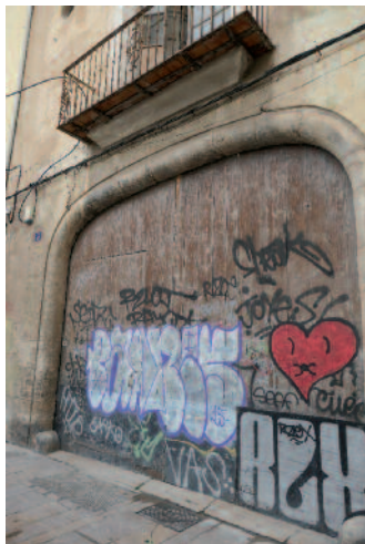
Un aspecte de la degradaci   del barri de Velluters
