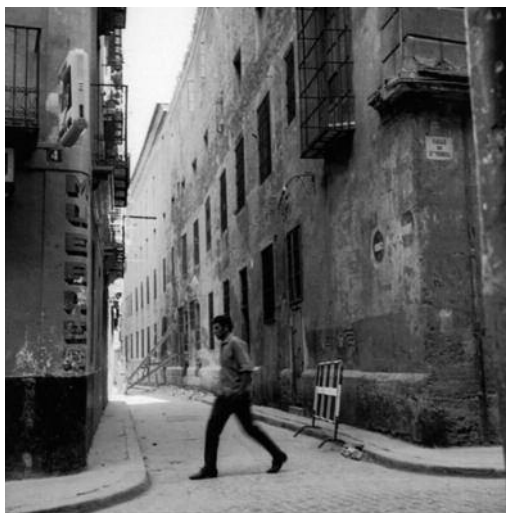
Enderrocament del palau del comte de Parcent
