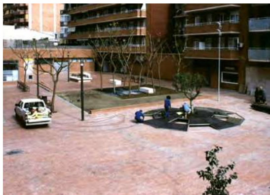
Fig. 20. La plataforma durante su instalación y montaje.
